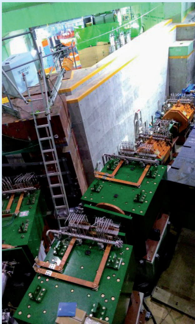
Construction de la ligne de faisceau de protons (ligne-C) dans le hall expérimental de physique nucléaire de J-PARC. La ligne-C doit transporter le faisceau de protons de 8 GeV vers la cible de proton de l'expérience COMET. Les muons utilisés dans cette expérience sont générés à partir de la désintégration des pions produits dans la cible de proton. La construction de la ligne-C devrait être achevée en 2022.
